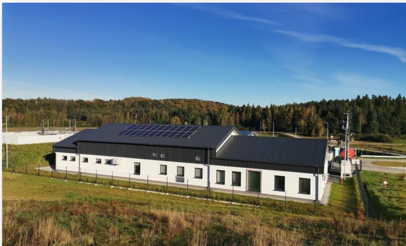
Oczyszczalnia ścieków Przywidz
