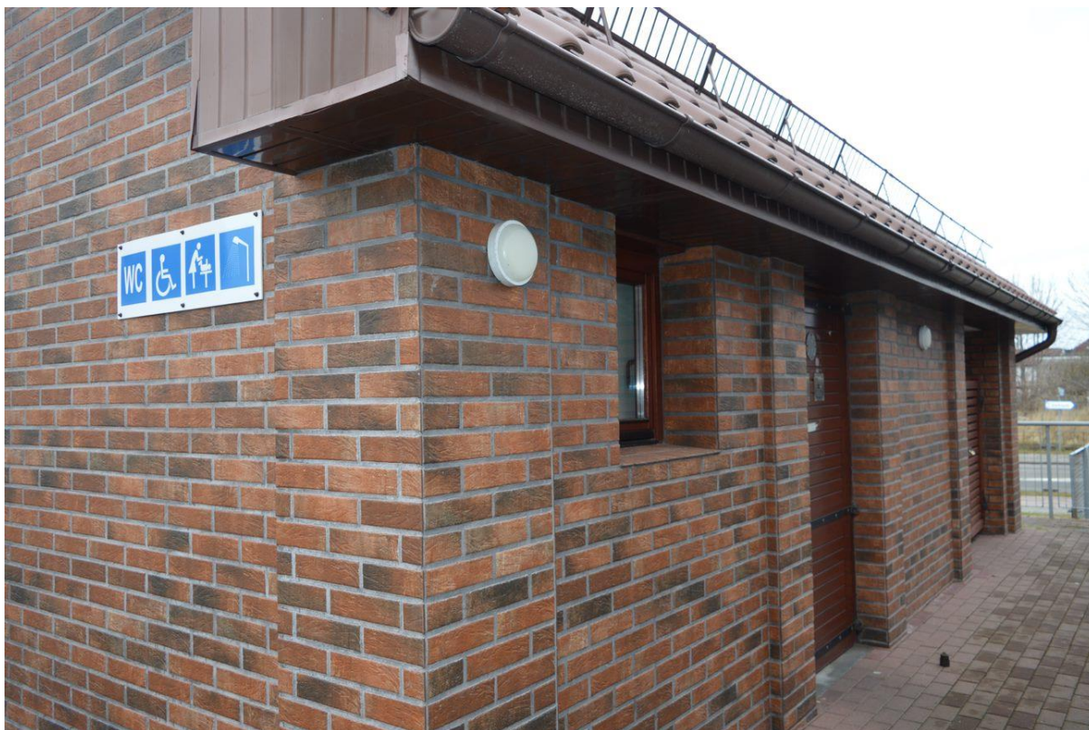
Zdjęcie 7. Węzeł sanitarny w marinie w Jastarni, wybudowany w ramach RPO WP.
