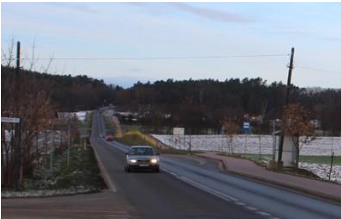
Rysunek 38. Niezniwelowany teren pod ciągiem pieszo-rowerowym na drodze wojewódzkiej nr 229
