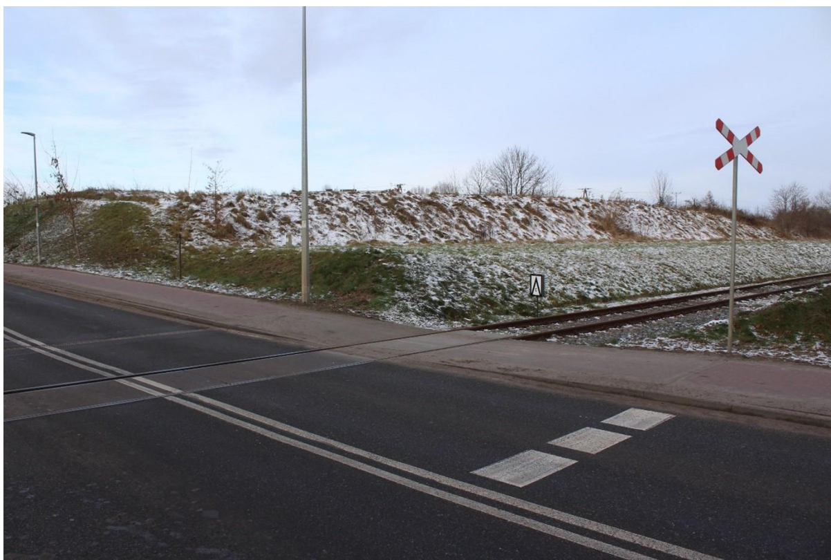
Rysunek 24. Zmodernizowany przejazd kolejowy z linią kolejową nr 243 w ciągu drogi wojewódzkiej nr 229
