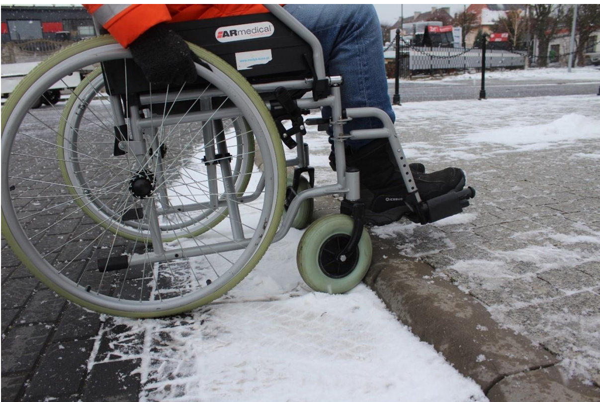
Rysunek 34. Brak obniżonego krawężnika w drodze na dworzec w Człuchowie
