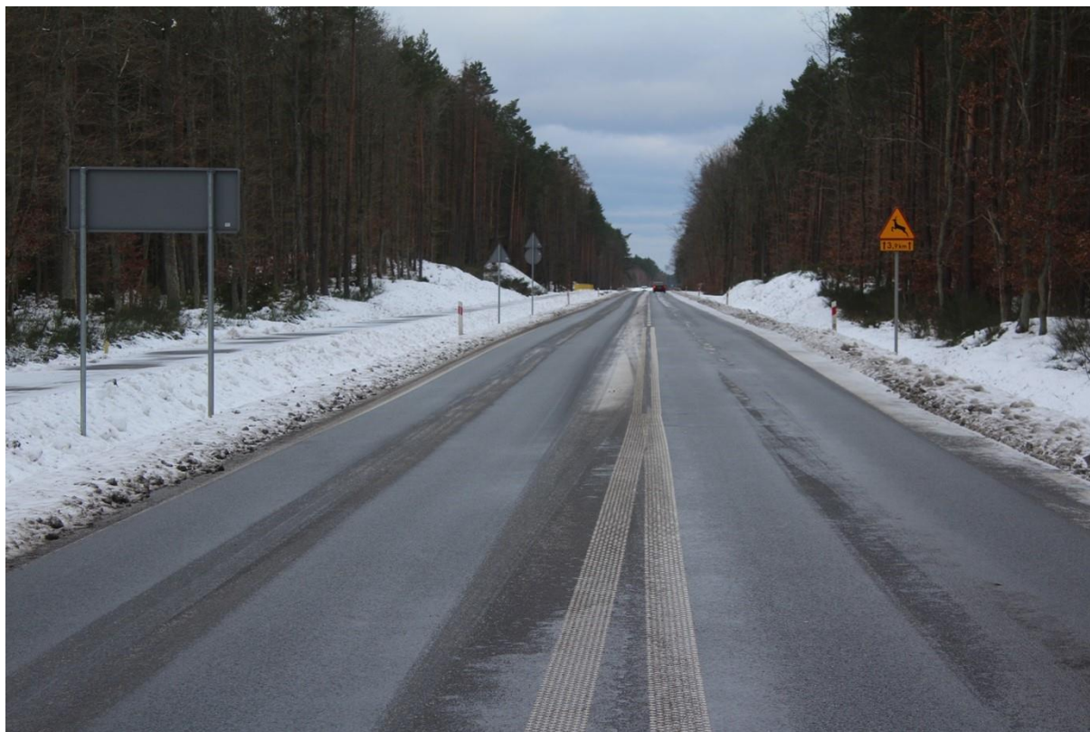
Rysunek 32. Standard zmodernizowanej drogi wojewódzkiej nr 214 ze zlokalizowanym po lewej stronie drogi ciągiem pieszo-rowerowym
