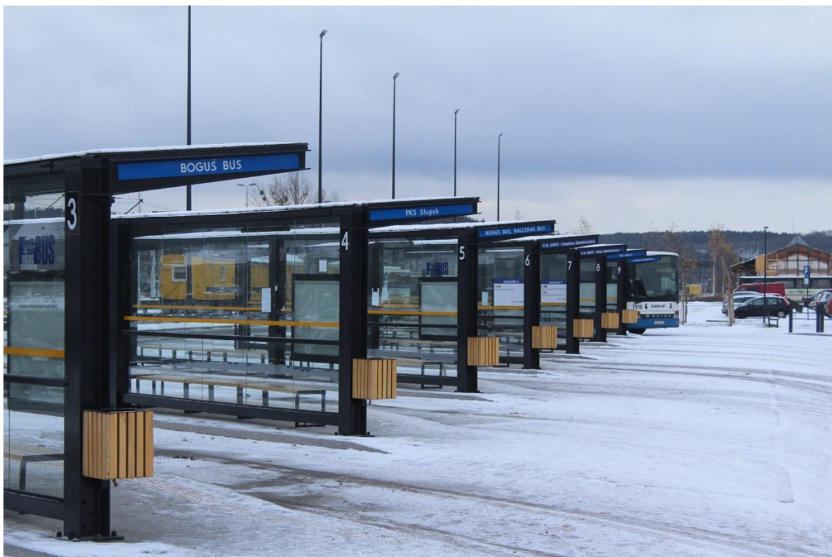
Rysunek 8. Dworzec autobusowy w ramach węzła integracyjnego w Lęborku
