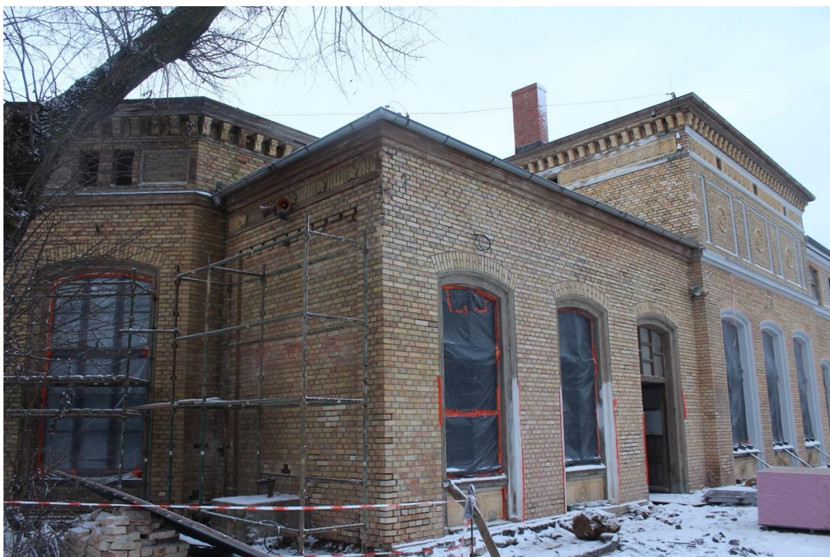
Rysunek 6. Remont dworca kolejowego w Chojnicach dofinansowany w ramach RPO WP
