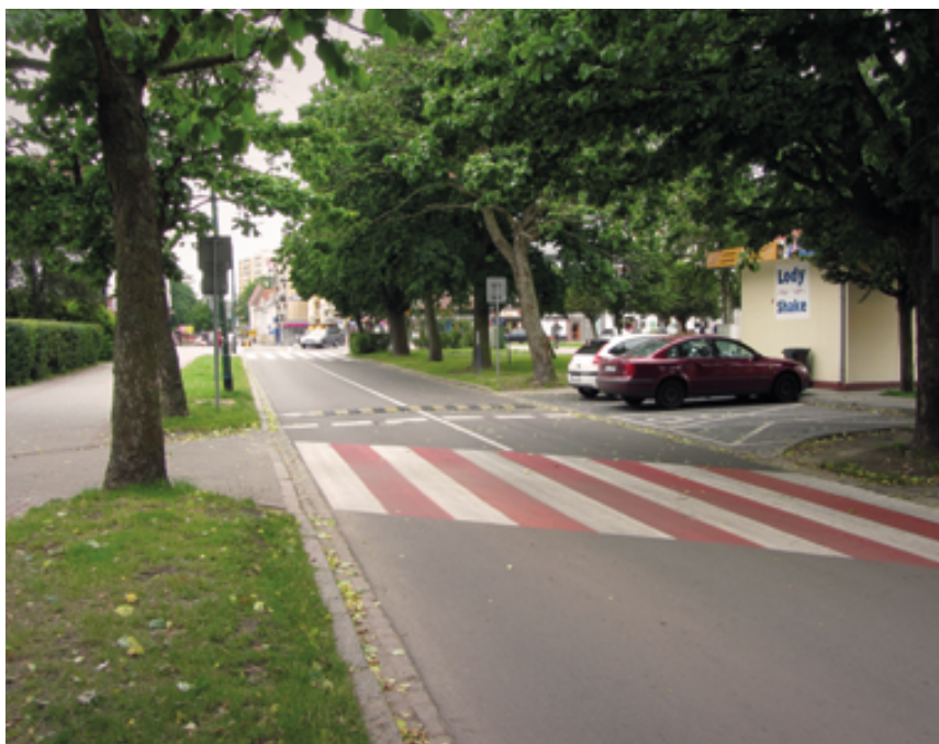
Kołobrzeg, przejście dla pieszych wyznaczono na ukos, zgodnie z kierunkiem ciągu pieszego. Tak, aby to pieszy miał najkrótszą drogę.
