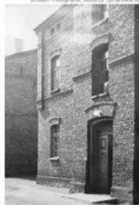
Fot. 4: Dom, ul. Kościuszki. Widok elewacji od strony podwórza.
