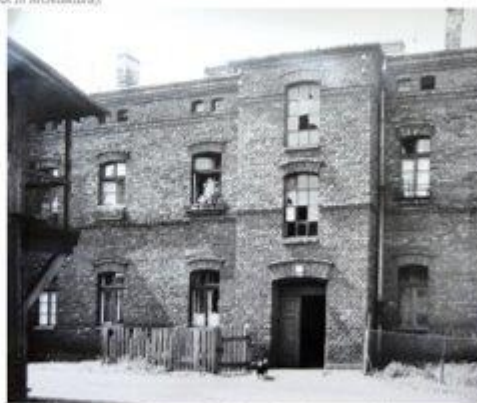
Fot. 5: Dom, ul. Wyszyńskiego. Widok elewacji od strony podwórza.
