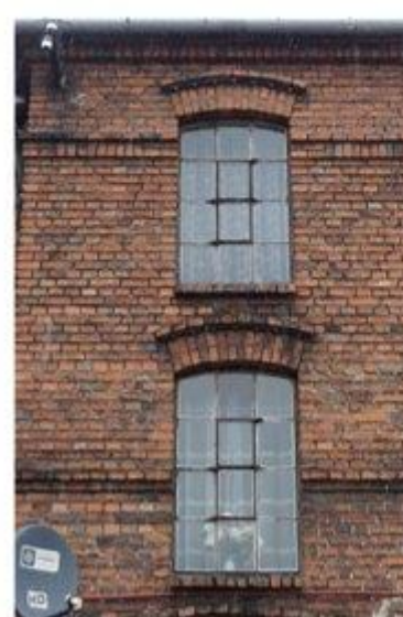
Fot. 3: Stolarka okienna, typ O-01. Fragment elewacji.
